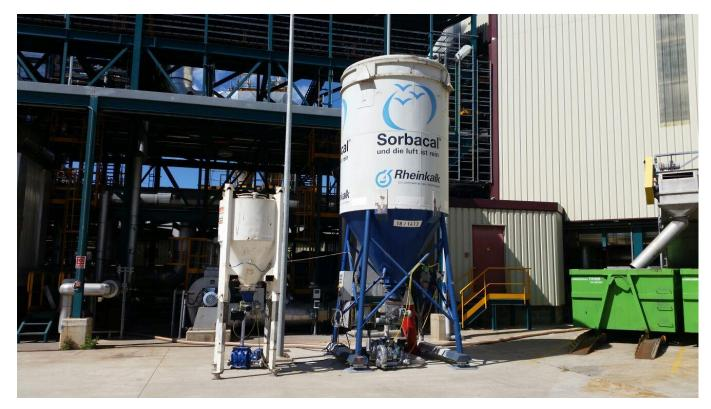
$1m^{3}$ -Silo & Dosing (5 – 50 kg/h) unit for: - CaCO<sub>3</sub>/AC-Blend (no ATEX)
